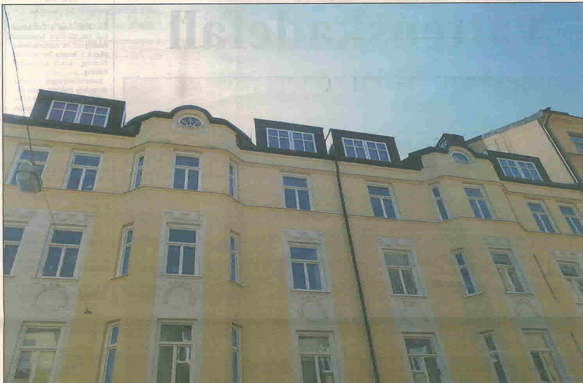
Det gäller att tänka efter före vid en större ombyggnad av vinden. Bilden ovan visar ett exempel, som ur det här perspektivet inte ser alltför avskräckande ut. Trots det har bl.a. de nya takkuporna svarlistats av Stadsbyggnadskontoret i Stockholm, som med hot om böter på en miljon kronor måste byggas om enligt utfärdat bygglov. En annan förening i city hotas på motsvarande sätt av böter på dubbla summan, 2 miljoner kronor, även det efter en alltför avvikande ombyggnad av vinden.
